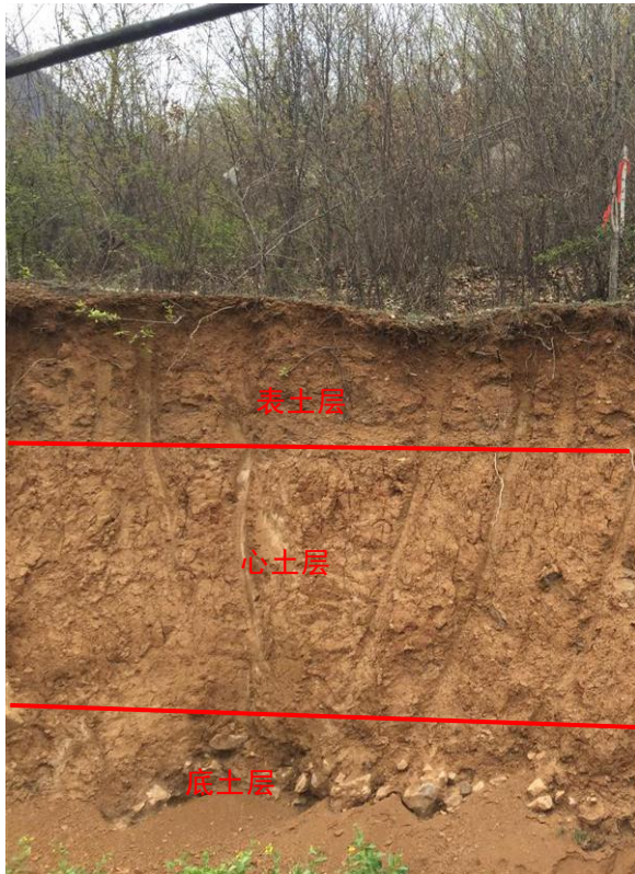
照片2-3 主井场地边坡剖面
