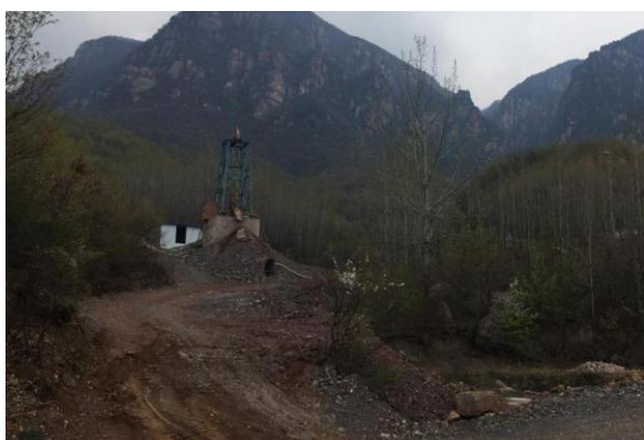
照片 1-3 风井工业场地
